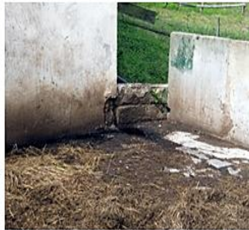
Dungplatte undicht...
